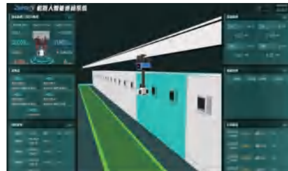
■ 机房智能巡检管理平台
