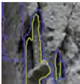
混凝土脱落
